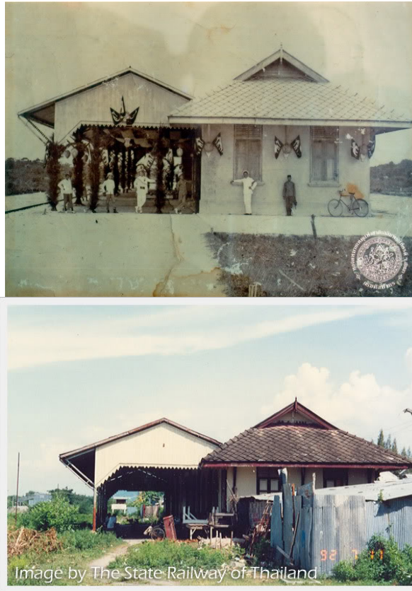
รูปที่ 4 สภาพอาคารสถานีรถไฟหาดใหญ่ในอดีตและปัจจุบัน
